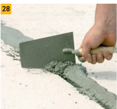
28. Beton v drážkách zarovnáme a uhladíme zednickou lžící.
