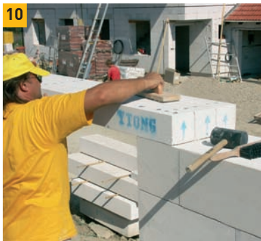
10. Případné nerovnosti povrchu nebo tloušťku zarovnáme hoblíkem.
