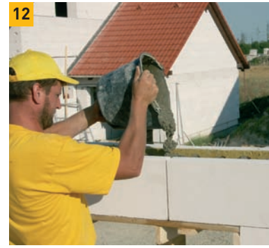
12. Betonujeme v menších úsecích betonem min. třídy C16/20.
