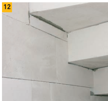
12. Stupně schodiště sesazujeme tak, že vzniklou vodorovnou mezerou mezi stupni dosáhneme podle potřeby výšku kroku stupňů v rozmezí mezi 150 až 195 mm.
