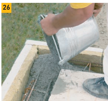
26. Po uložení celé výztuže můžeme přikročit k betonáži věnce. Při opatrném postupu není třeba dodatečná fixace věncových tvárnic, které jsou přilepené zdicí maltou a tvoří potřebnou tepelnou izolaci i ztracené bednění pro věnec.
