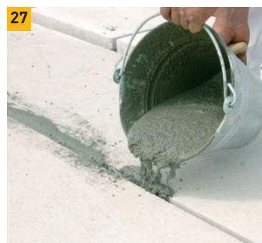
27. Současně s betonáží věnce můžeme přistoupit i k zalití drážek mezi dílci. Použijeme betonovou směs s velikostí zrna max. 4 mm vhodné konzistence.
