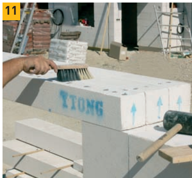
11. Horní plochu důkladně očistíme od prachu a nečistot.
