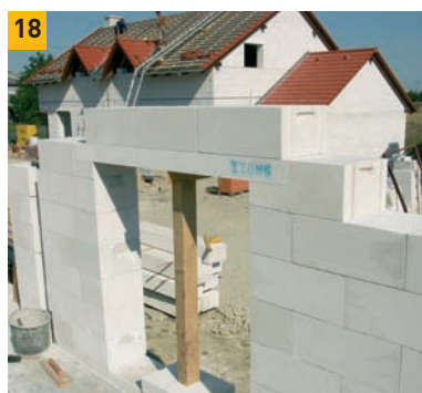
18. Po vytvoření překladu dozdíme zbytek zdi do stejné výšky.
