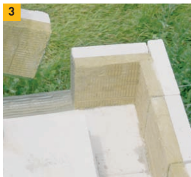
3. Důkladnost slepení zaručí, že věncová tvárnice udrží i tlak betonu při opatrné betonáži věnce.
