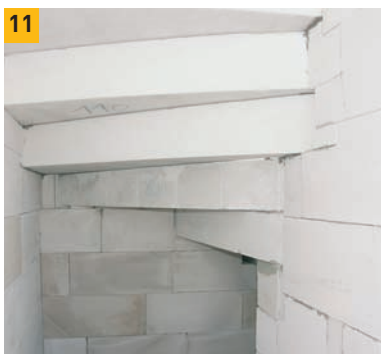
11. Využitelný prostor pod schodištěm.
