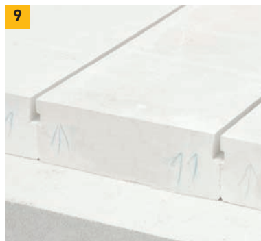
9. Správně položené dílce jsou v čele zalicované a přiražené těsně jeden k druhému. Na čele každého dílce je vždy šípka, která musí směřovat vzhůru.
