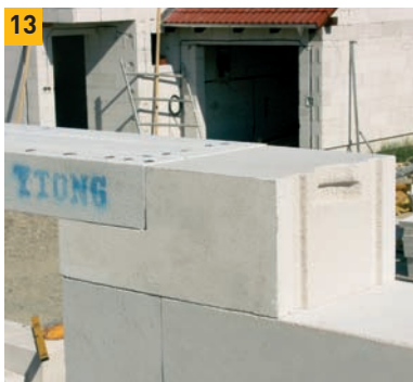
13. Jako alternativu můžeme trámce zapustit 125 mm do tvárnic.
