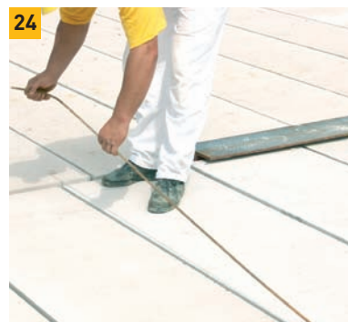
24. - 25. Výztuž v zalévacích drážkách je zafixovaná do armování středového a obvodového věnce.
