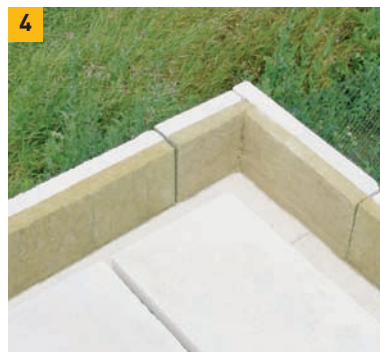
4. Při převazování rohů dbáme na správné přiložení izolace.
