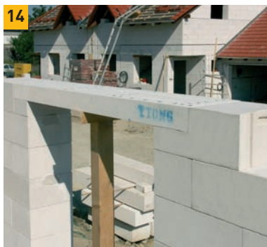
14. Trámce nad otvory šířky 1250 mm a více je nutné uprostřed montážně podepřít.
