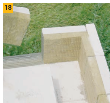
18. Obvodové zdi vyzdíme na okraji věncovými tvárnicemi. Pracujeme pečlivě, lepíme i čela (tvarovek). Dbáme na správné připojení tepelné izolace v rozích.
