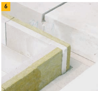
6. V případě rohu je třeba také převázat izolaci, aby se zabránilo vytvoření tepelného mostu.
