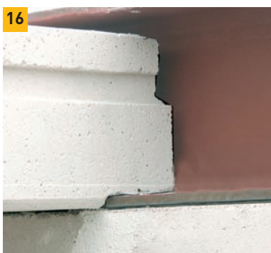
16. Správně položený dílec do ocelového profilu je uložen min. 80 mm.
