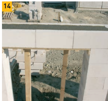
14. Horní plochu betonového jádra zarovnáme, U-profily teď tvoří ztracené bednění.
