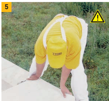
5. Kontrolujeme dostatečnou délku uložení dílce na vrchol zdi, která nesmí být menší než 100 mm.
