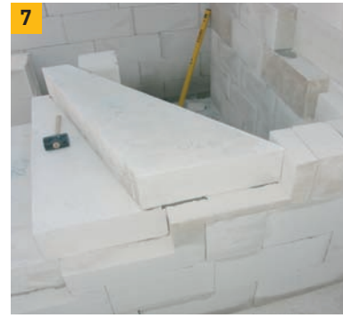
7. V případě pokládání stupně k již hotovým stěnám musíme přizdít stěnu tloušťky 150 mm a stupně budou tedy podezděné. Tento způsob uložení využijeme především při rekonstrukci nebo dodatečném vytvoření schodiště. Výhodou je, že požadované rozmístění stupňů si můžeme vyznačit na již existující stěnu.
