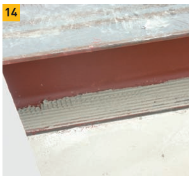
14. I do ocelového nosníku klademe dílce na tenkovrstvou zdicí maltu.
