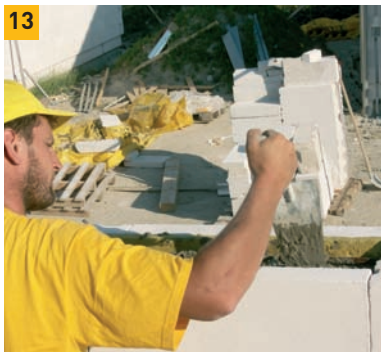
13. Betonovou směs průběžně zhutňujeme.
