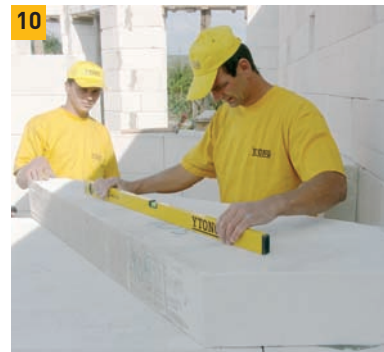
10. Kontrola vodorovného sesazení v obou směrech je nezbytná.
