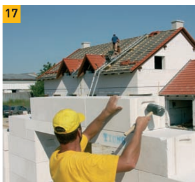
17. Přesnosti sesazení tvárnic dosáhneme poklepem gumovou paličkou.
