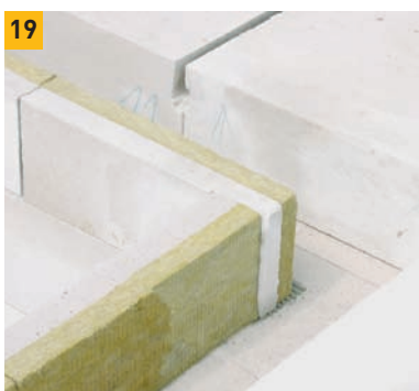
19. Dbáme na správné připojení tepelné izolace věncových tvárnic v rozích.
