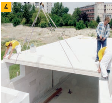
4. Správné usazení panelů zabezpečí nejlépe dva pracovníci.
