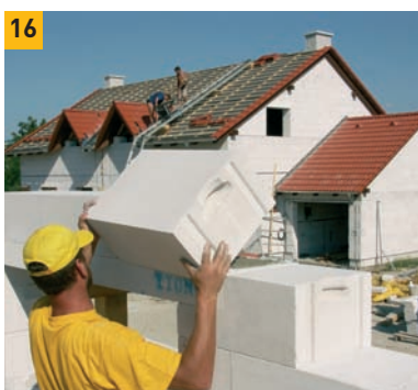
16. Tvárnice klademe na trámce do tenkovrstvé zdicí malty Ytong a dbáme na to, aby malta byla nanesena na celou plochu zdiva.
