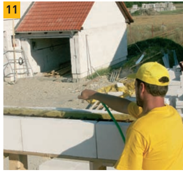
11. Před betonáží jádra překlad zvlhčíme vodou.
