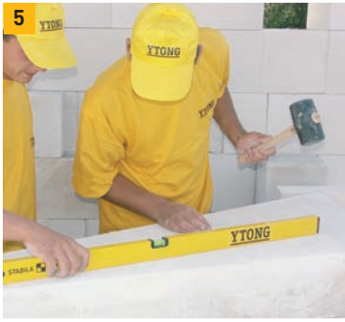
5. Kontrolujeme rovinnost a výškové usazení každého stupně.
