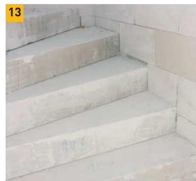
13. Po sesazení stupňů dozdíme schodišťové zdi až po horní úroveň ostatních nosných stěn.
