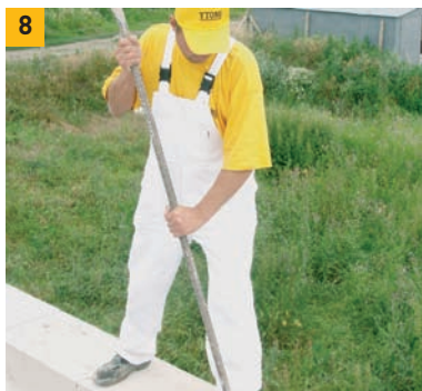
8. Pomocí ocelového páčidla odtlačíme na čelech dílec těsně k dalšímu dílci.
