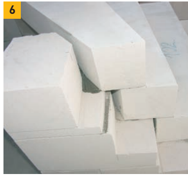
6. Vzniklé klíny ve středním zdivu později vyplníme odřezky z pórobetonu. Uložení stupně musí být min. 150 mm.
