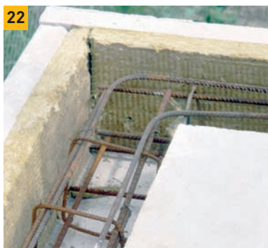
22. Zajistíme propojení vodorovné výztuže v rozích stavby.
