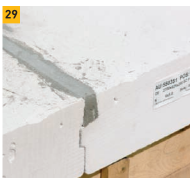
29. Detail zalévací drážky.
