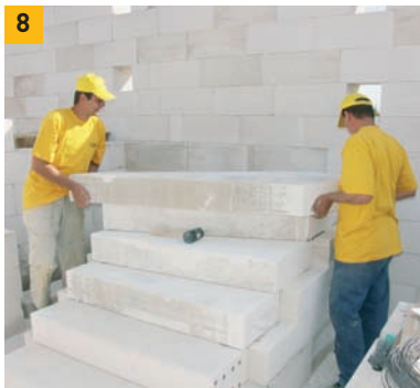
8. Příprava uložení dalšího stupně. Stupeň dokáží vždy ručně unést dva pracovníci.
