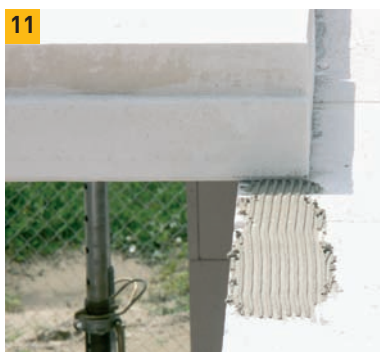
11. Přesnost a preciznost při zdění zajistí rovné zakončení zdi. Případné nerovnosti zahladíme hoblíkem.
