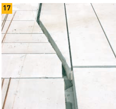
17. Snadno se řeší i různé šikminy v nosném zdivu. Čela dílců se seřezou přímo na stavbě. Výztuž dílce musí být samozřejmě na tuto úpravu již při výrobě uzpůsobena. Nad střední zdí vznikne mezera, do které se vloží výztuž (nejlepší je žebřík se dvěma podélnými pruty \varnothing 10 mm).
