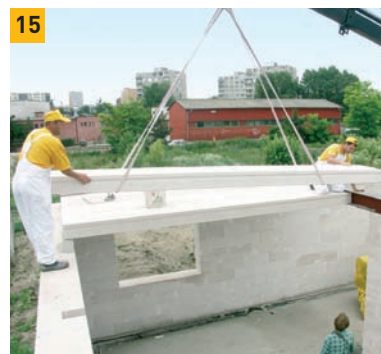
15. Při pokládání dílců zasuneme nejdřív konec dílce do ocelového profilu a pak druhý na zeď.
