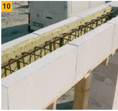
10. Správně sestavený překlad před betonáží.
